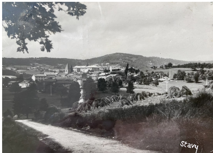
La Route de Saillant (Le Mont - Hauteville - etc.) dit Route de St Bonnet le Château en 1949. Elle est en terre battue et sera goudronnée que bien plus tard.
